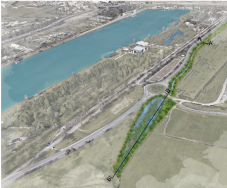
SEGRATE - VIA Mondadori - BACINO DETENZIONE NBS
