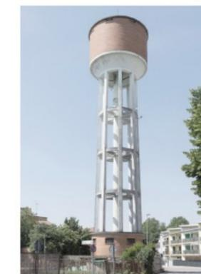
Fig. 0.2 Serbatoio tipo "Himze"
