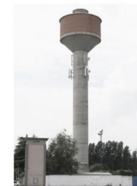
Fig. 0.4 Serbatoio "a fungo" con vasca cilindrica
