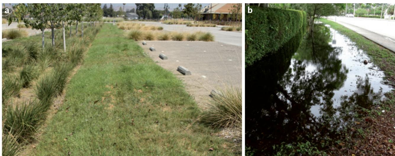
Figura 36. Bioswale, trincee filtranti prima (a) e dopo (b) l'evento di pioggia
