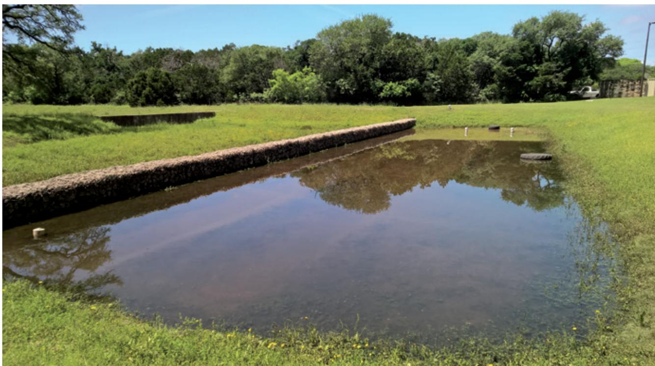
Figura 45. Esempio di un piccolo bacino di infiltrazione riempito dopo una precipitazione intensa.
