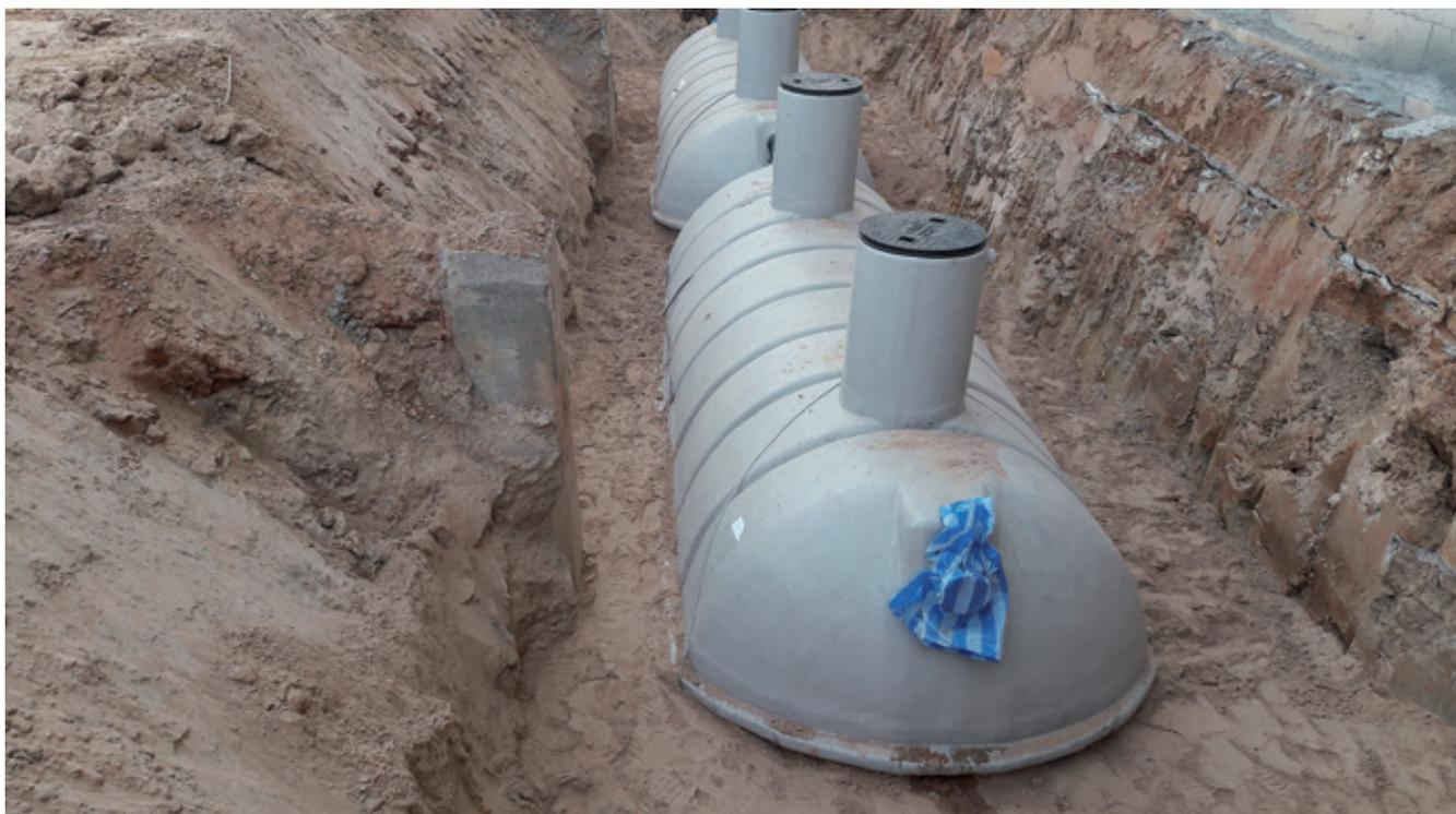
Figura 26. Esempio di installazione di una cisterna sotterranea per la raccolta delle acque piovane.
