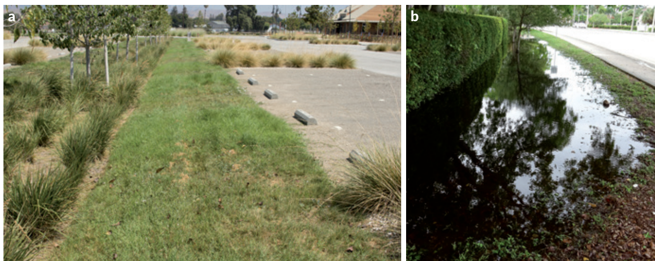
Figura 36. Bioswale, trincee filtranti prima (a) e dopo (b) l'evento di pioggia
