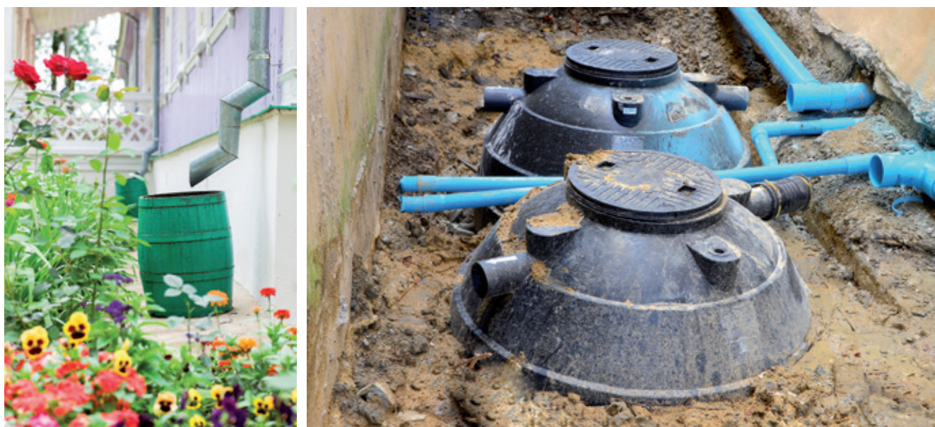
Figura 23. (a) Esempio di cisterna domestica per la raccolta delle acque piovane. (b) Esempio di cisterna sotterranea
