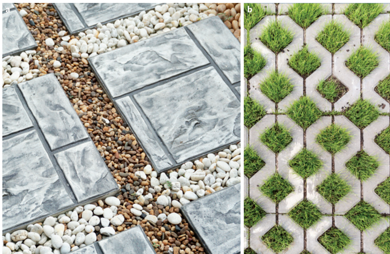
Figura 39 (a) Pavimentazioni permeabili con materiali a diversa granulometria. (b) Pavimentazioni permeabili con essenze vegetali
