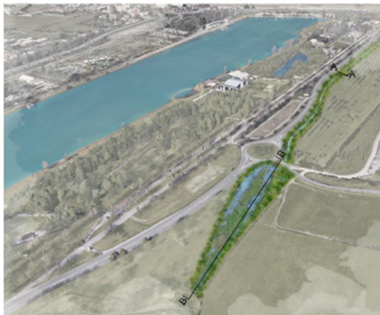
SEGRATE - VIA Mondadori - BACINO DETENZIONE NBS
