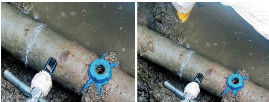
Figura 16 - Particolare del punto di derivazione.
