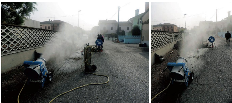
Figura 5 - Cannone nebulizzatore nell'area d'intervento.
