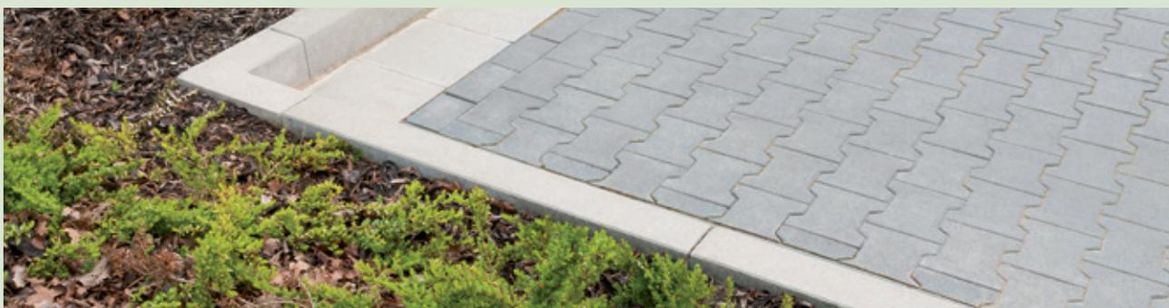
Figura 38. Area parcheggio con predisposizione di elementi filtranti.
