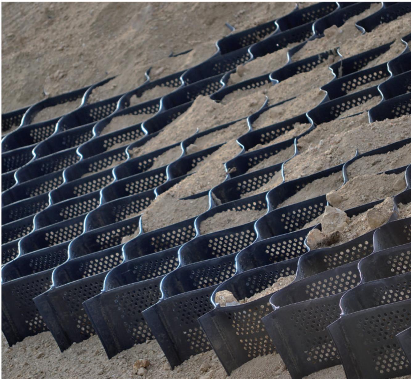
Figura 31. Esempio di sistemi modulari geocellulari
