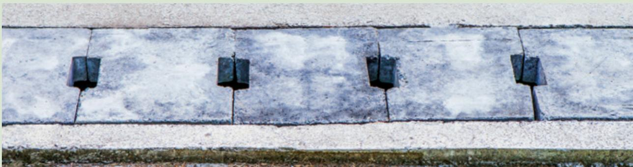
Figura 37. Esempio di caditoia filtrante a bordo strada.
